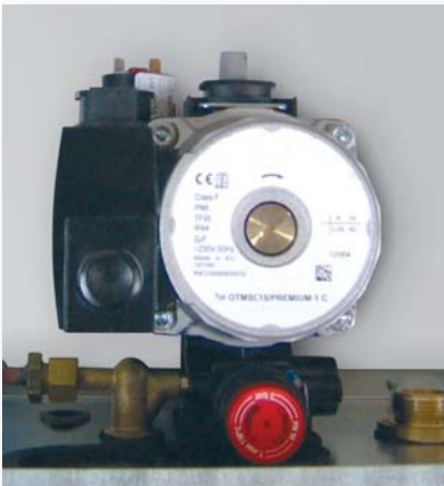
Tělo čerpadla se zabudovaným odvětráním
